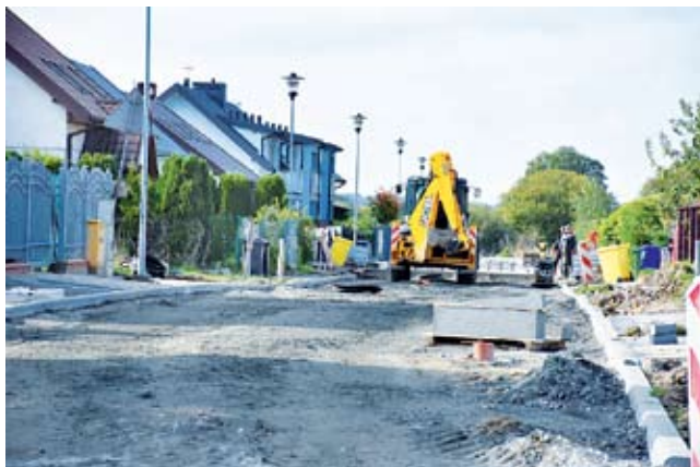
Sianożęty: ulice Liliowa i Wczasowa w trakcie remontu
